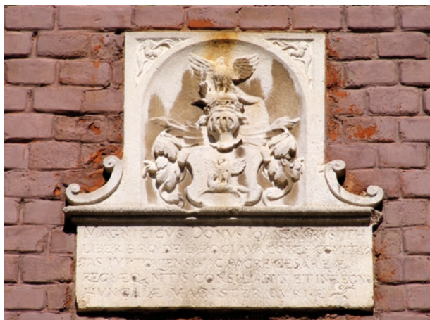
Erb Jána Krušiča s nápisovou tabuľou druhotne osadený na západnej fasáde vežovej prístavby východného krídla
