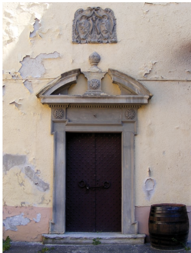
Ranobarokový portál na dvorovej fasáde južného krídla
